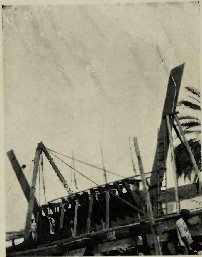
Construção da porta-batel para o dique "Santa Cruz".
