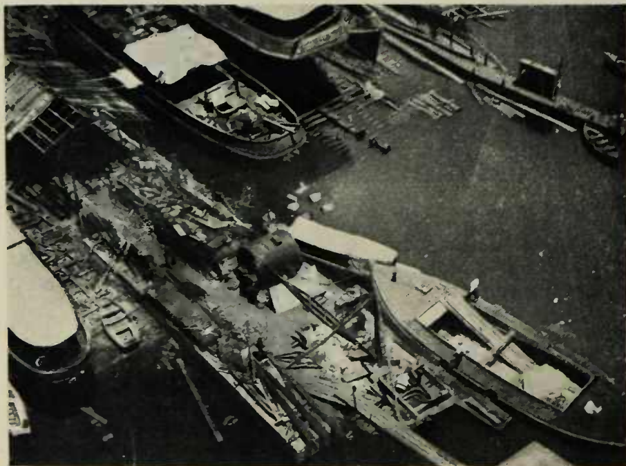
Vista parcial das carreiras da firma Prado Peixo'o & C. tomada de aeroplano
