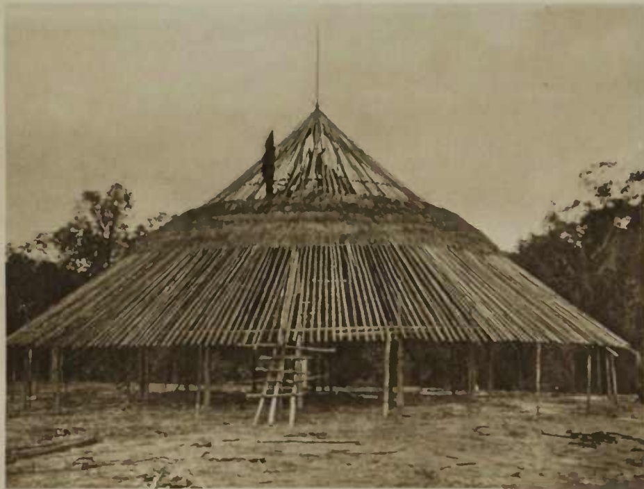
Bau einer Kegeldachhütte der Yekuaná-Ihuruána, Rio Ventuari: 1 Festbinden der Dachsparren mit Schlingpflanzen. 2 Decken des Daches mit Palmblättern.
