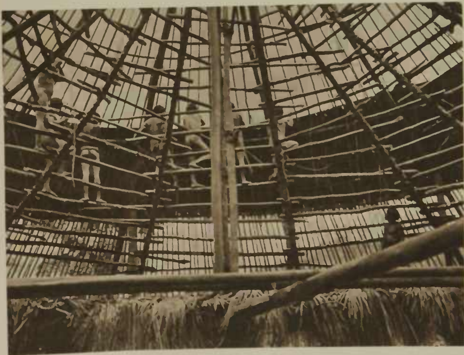
Bau einer Kegeldachhütte der Yekuaná-Ihuruána, Rio Ventuari. Decken des Daches von innen nach außen mit Palmblättern. Die Indianer arbeiten auf einem Leitergerüst, das bis in die Spitze des Daches reicht und nach Fertigstellen der Arbeit abgerissen wird.
