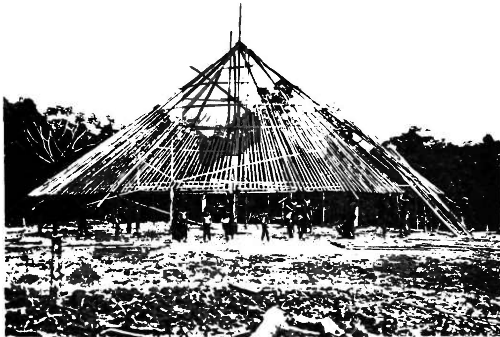
97. Neubaugerüst von Mauakunya.
