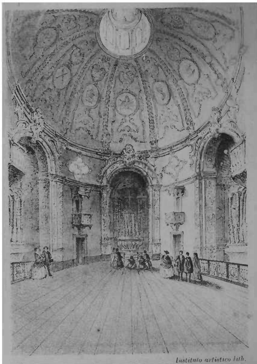
INTERIOR DA IGREJA DE S. PEDRO.
