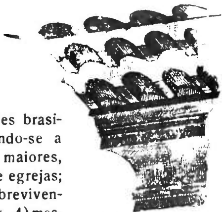
Fig. 4 — Beiral de telhas e cantaria (Santos)
